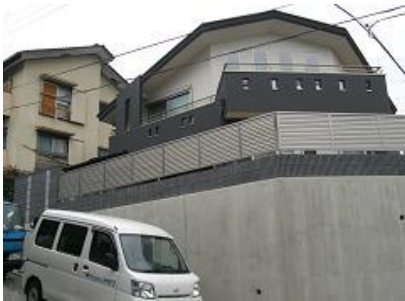
コンクリート擁壁上に目隠しルーバーフェンスを設置
