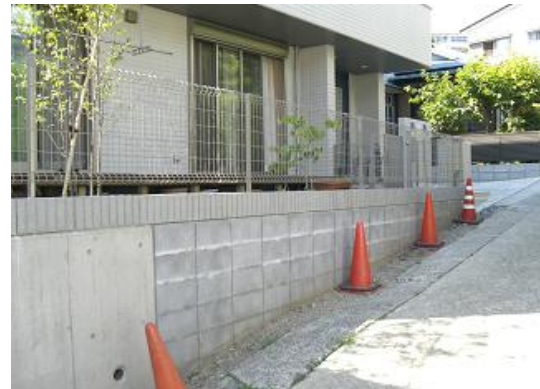
施工前の状態です。
