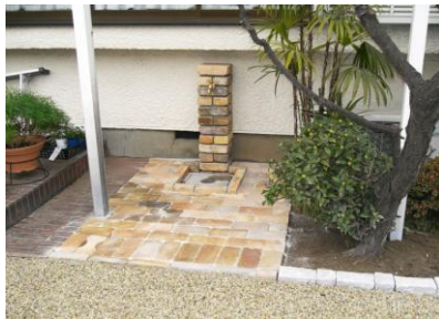
洗い場を広めにとったレンガ水栓
