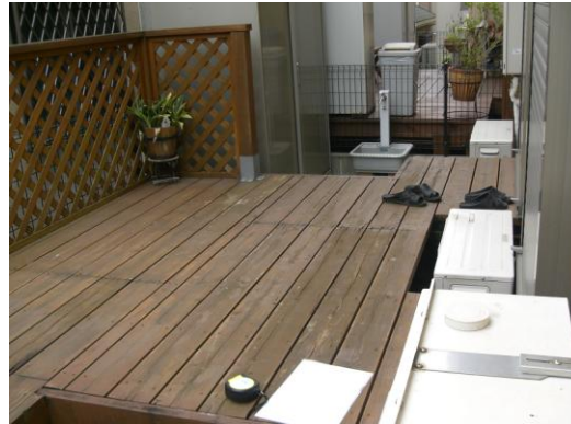
施工前の状態です。
