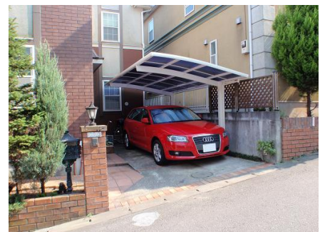
カーポートも施工いただきました。
