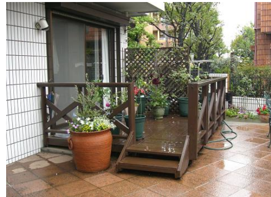
撤去した木製のテラス
